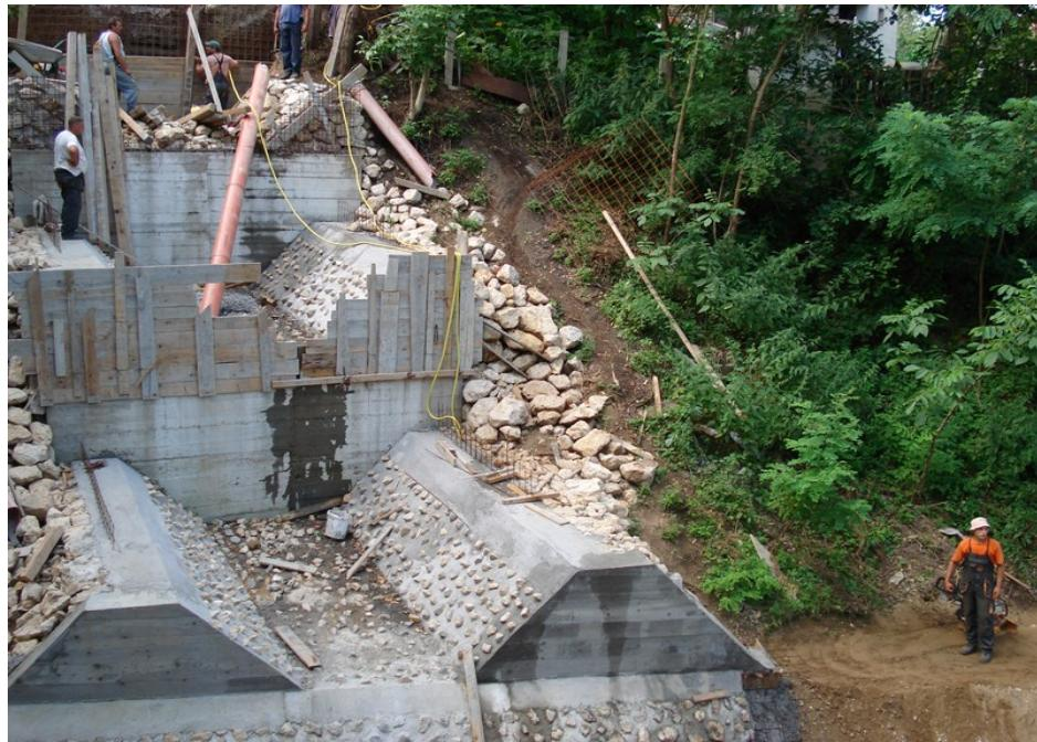
U naselju Tekija u toku su radovi na uređenju vodotoka Oduš, koji imaju za cilj sprečavanje erozije terena i obrušavanje okolnih objekata. Građevinski inženjeri, majstori i radnici ĐERDAP USLUGE grade potporne zidove i betoniraju obale kanala koji će odvoditi veće količine vode, koje su prisutne pre svega u prolećnim mesecima.
