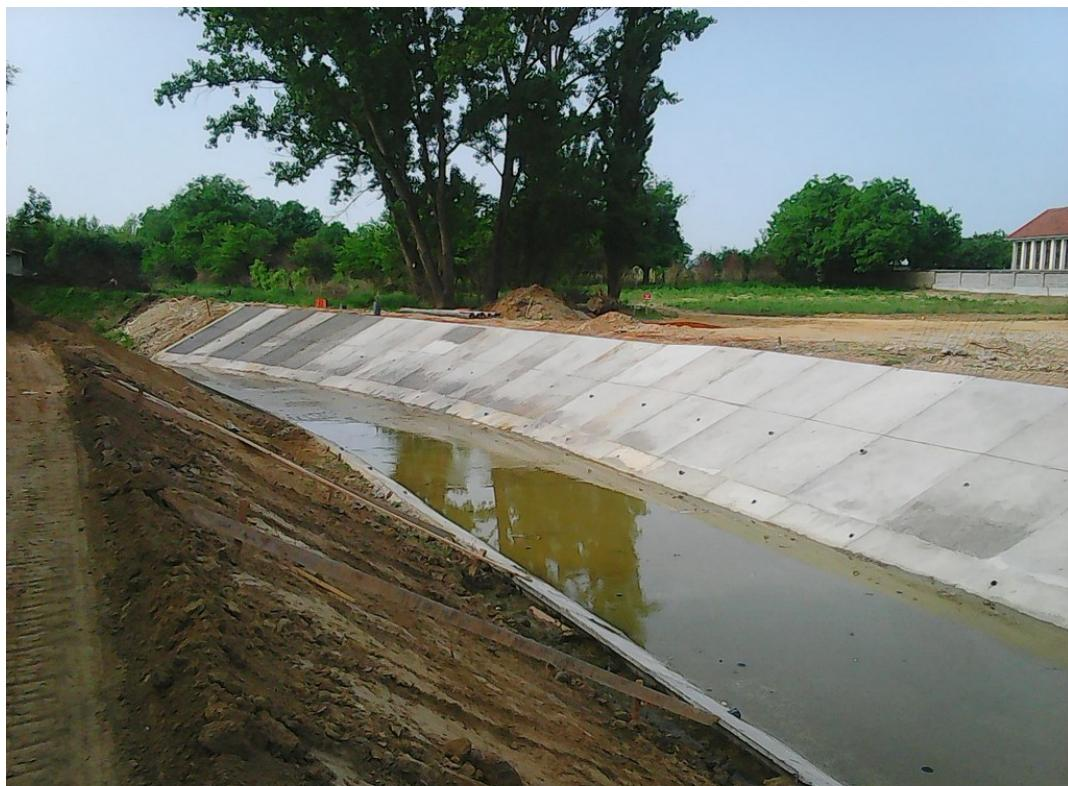
Kod površine kanala u Grabovici, učinkujući odvodnju atmosferskih i
