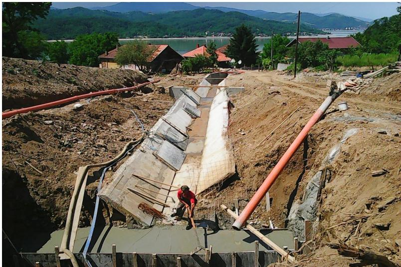
Privode se kraju radovi na realizaciji projekta Zaštita naselja Tekija od bujičnih voda, koji podrazumeva izgradnju većeg broja kanala kao i njihovo povezivanje u jedinstveni odbrambeni sistem.
