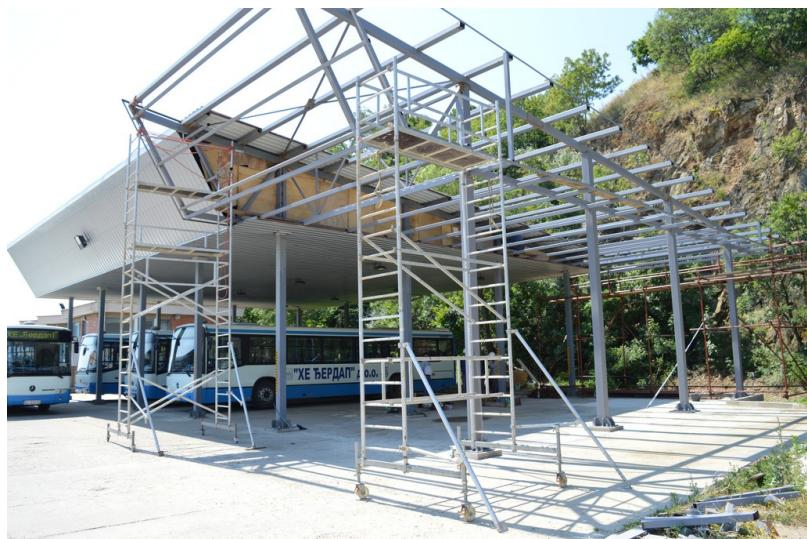
Radnici mašinske operative ĐERDAP USLUGE a.d. uspešno su završili radove na izradi nadstrešnice za specijalno vozilo dizalicu Lipher, u garažnom delu voznog parka hidroelektrane „Đerdap 1“.
