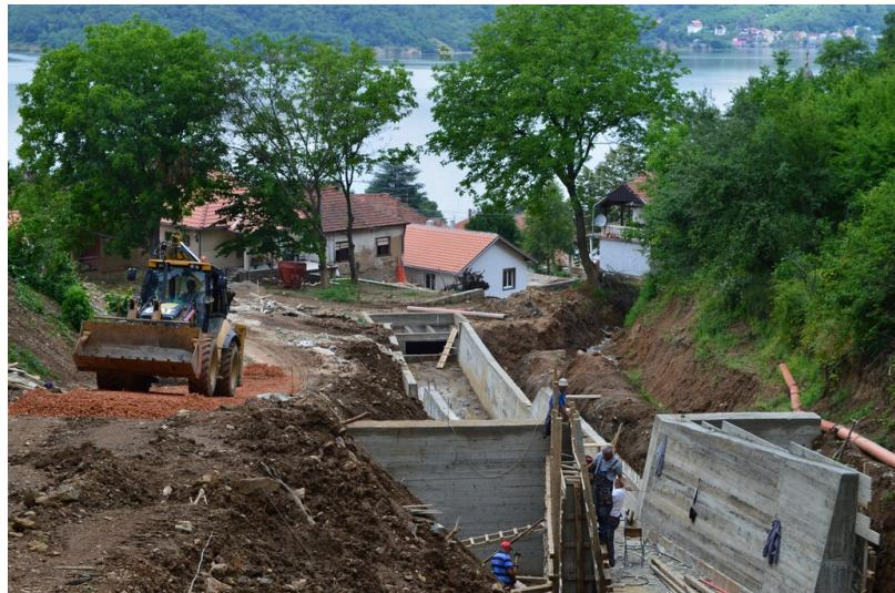
Nakon izgradnje centralnog odvodnog kanala kroz naselje Tekija, kao i kanala na lokaciji Stare štale, nastavljeni su radovi na podizanju tri zaustavne betonske brane.
